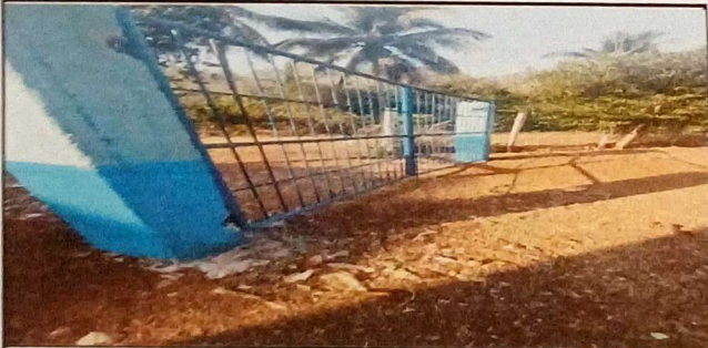
Foto 5: porton de ingreso instalado
