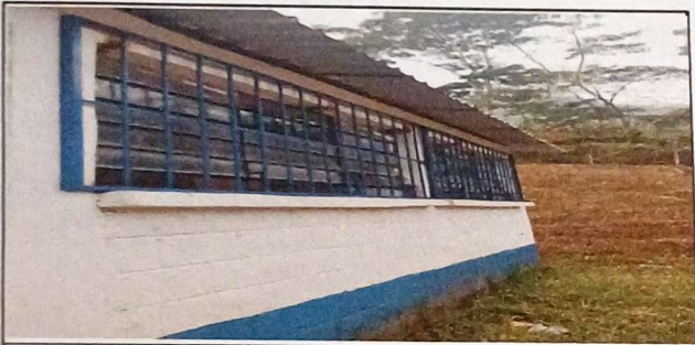
Foto 3: balcones colocados y terminados
